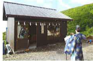
竣工した八合中社全景
